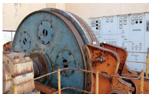
運搬立坑の巻上室。残されたままの大型巻上機や操作盤
