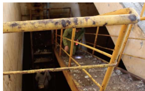
建物内部の階段。老朽化が著しく、昇る度に不安定に揺れ動く
