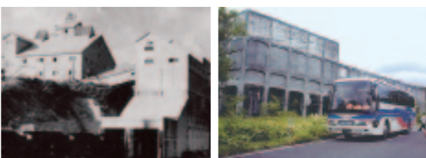
操業当時の第一選炭工場（築別坑） 一階部分を残すのみとなった現在の姿 ■「羽幌炭砒・三炭周遊コース」は下記へお問い合わせください 〒078-4103 北海道苫前郡羽幌町南3条2丁目 株式会社沿岸ハイヤー TEL: 0164-62-1551 ※ヤマ…炭砒の俗称
